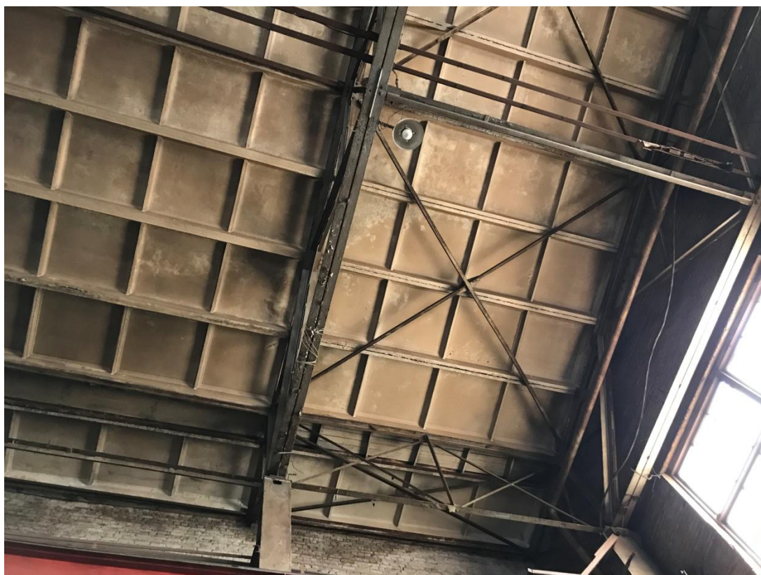
Фото 10. Общий вид покрытия в осях 10-12/Г-Д. Горизонтальная связь жесткости в уровне верхнего пояса ферм покрытия
