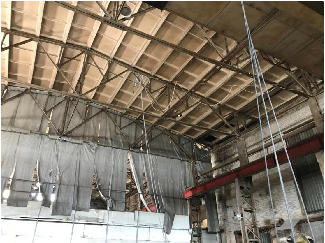
Фото 6. Общий вид внутри помещения в осях 7/А-Д. Подкрановая балка. Перегородка из профилированного металлического листа, разделяющая здание на 2 объема
