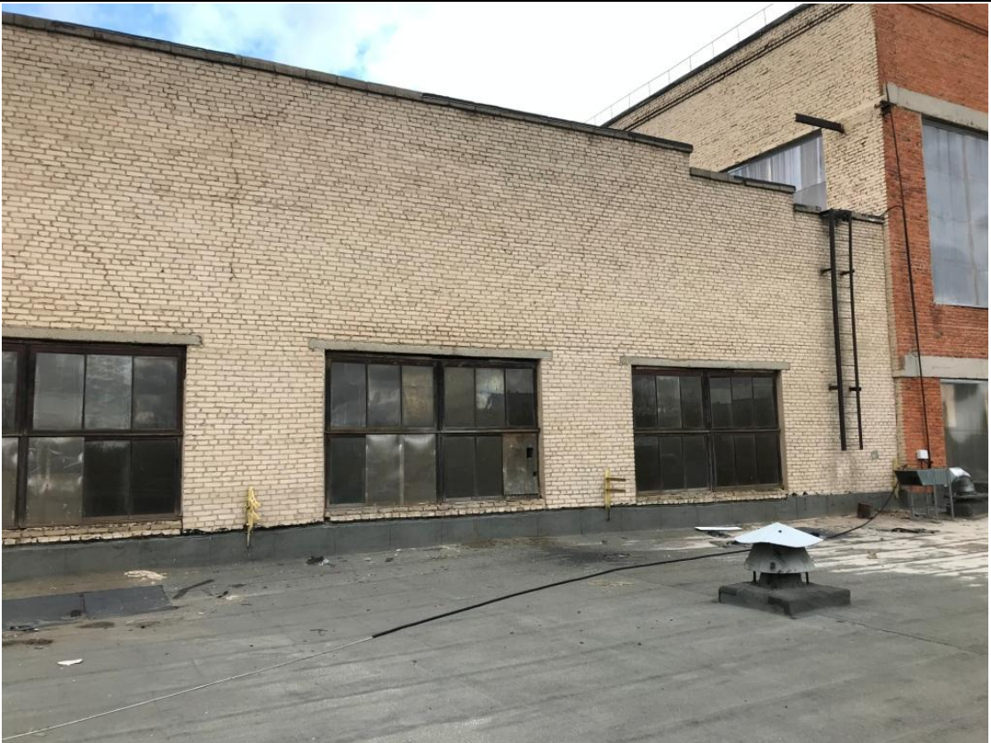
Фото 3. Фрагмент фасада в осях Б-Д. Заполнение проемов в виде деревянных окон
