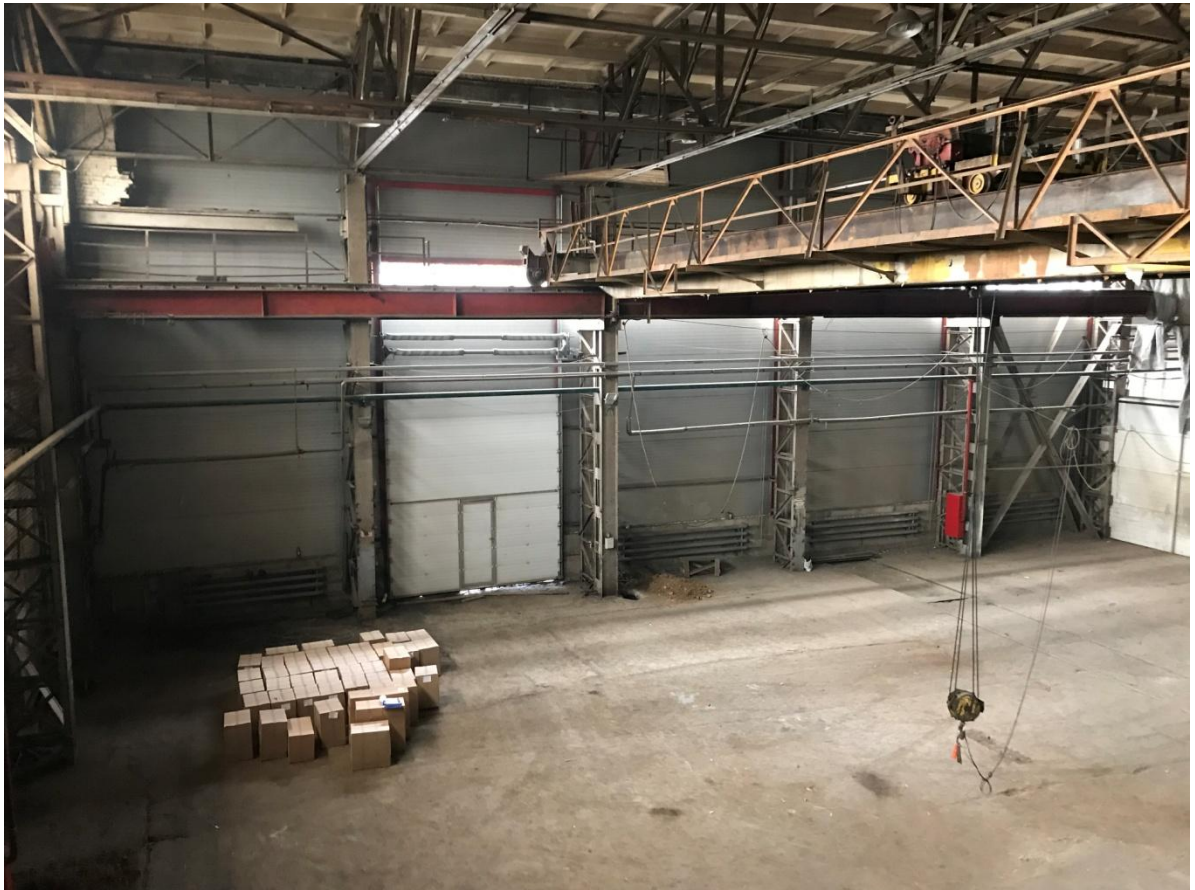
Фото 12. Общий вид здания в осях 7-12/А-Д. Общий вид электрокрана
