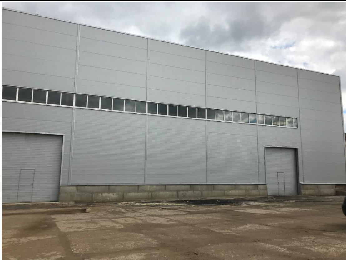
Фото 1. Фрагмент фасад в осях 6-12. Общий вид. Стены выполнены из сэндвич-панелей
