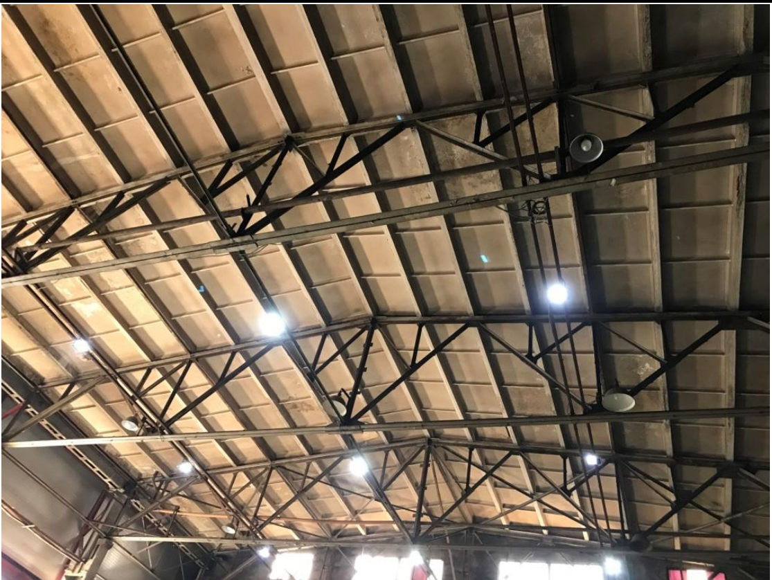
Фото 7. Общий вид конструкций покрытия. Сборные железобетонные ребристые плиты по металлическим фермам
