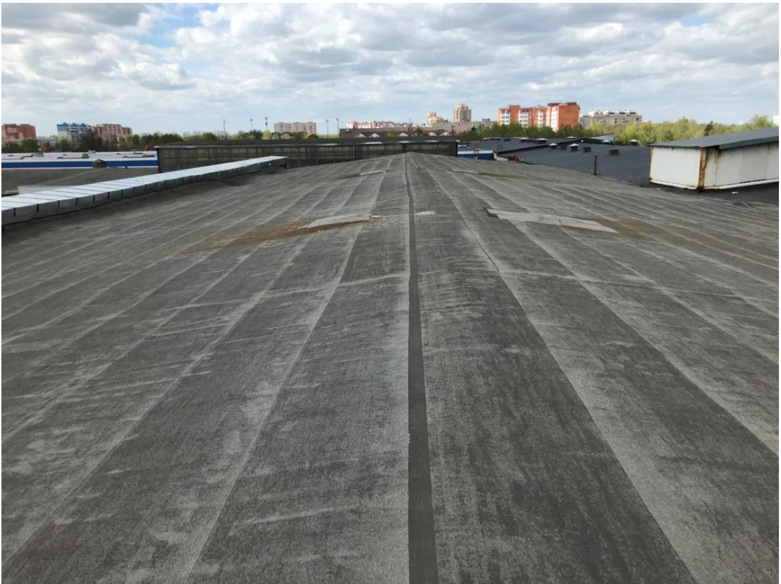
Фото 4. Общий вид кровли. Кровля мягкая рулонная
