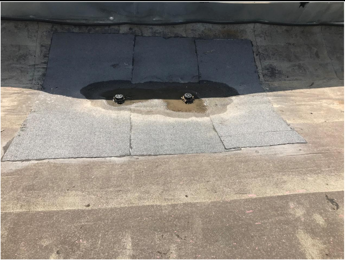
Фото 5. Водоприемные воронки на кровле
