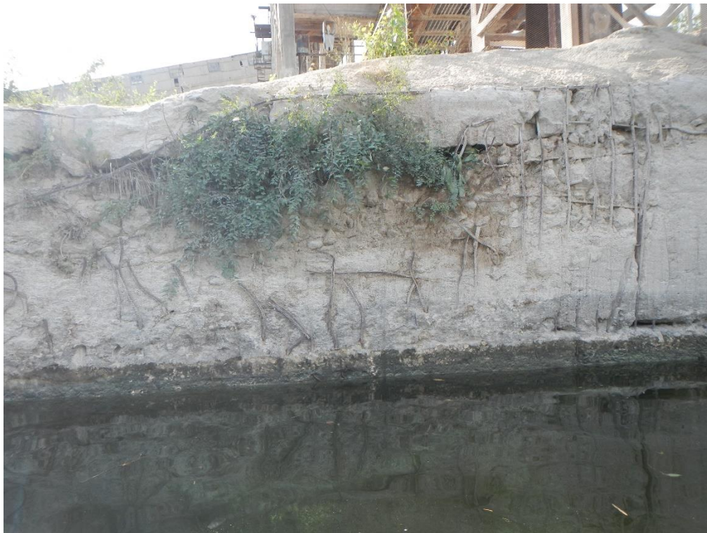
Разрушение бетона, оголение и коррозия арматуры у загрузочной эстакады
