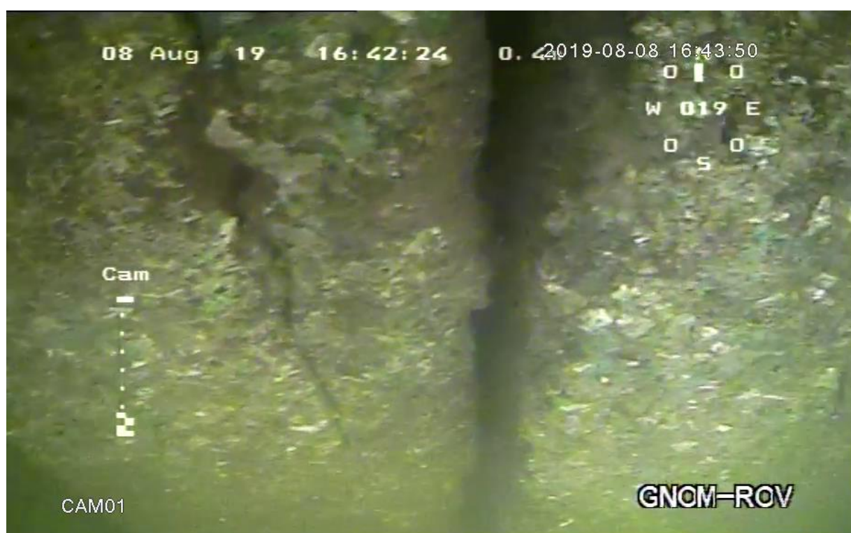
Продольные трещины в сваях переднего ряда
