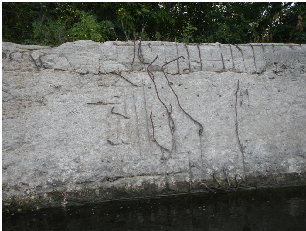
Состояние верхнего строения у левого открьлка
