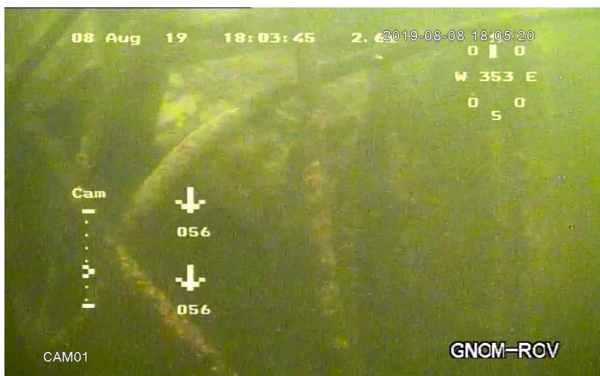
Полное разрушение железобетонных свай
