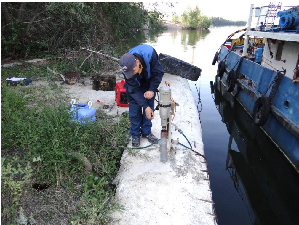
Выбуривание керна из верхнего строения
