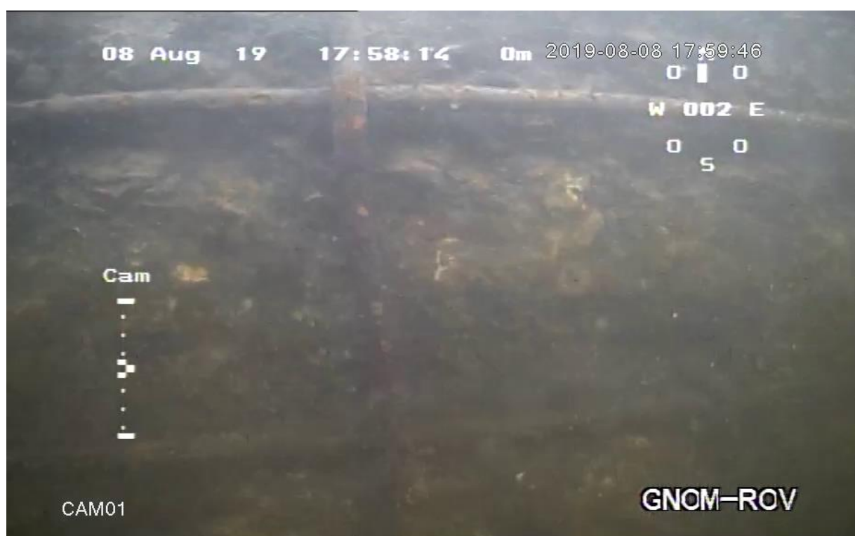
Разрушение бетона ростверка с оголением и коррозией рабочей арматуры
