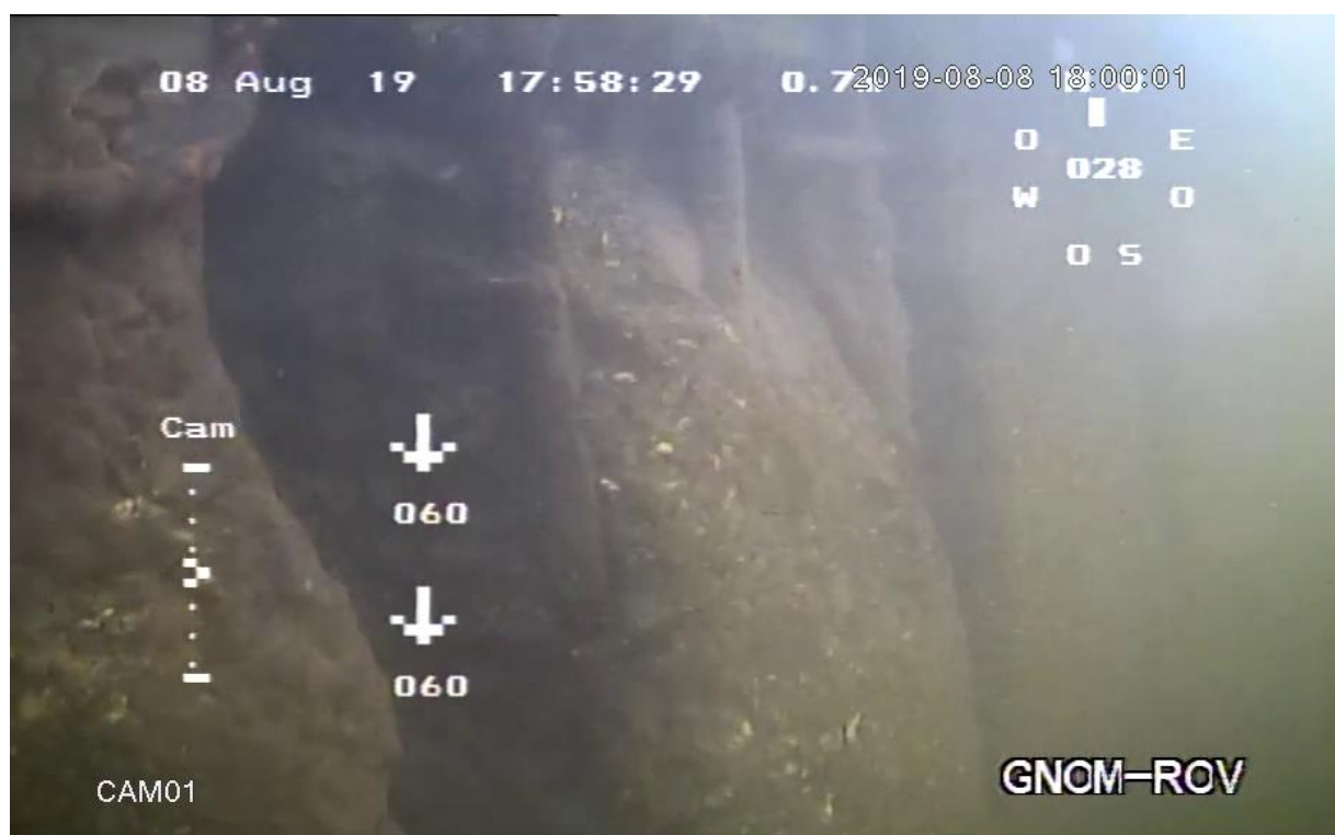
Разрушение бетона свай с оголением и коррозией рабочей арматуры
