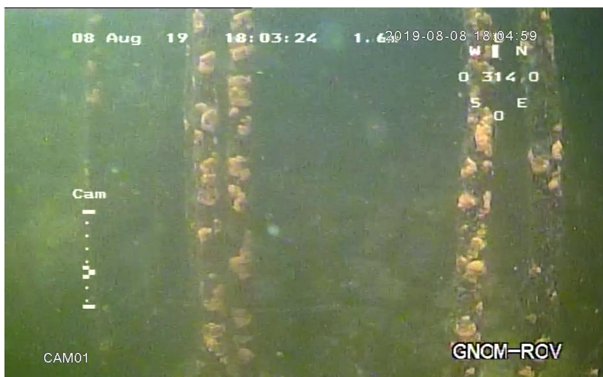
Полное разрушение железобетонных свай
