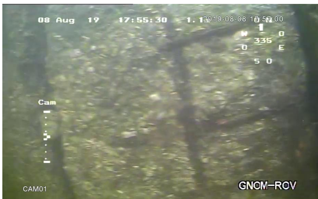
Разрушение бетона вереднего ряда свай с оголением и коррозией рабочей арматуры
