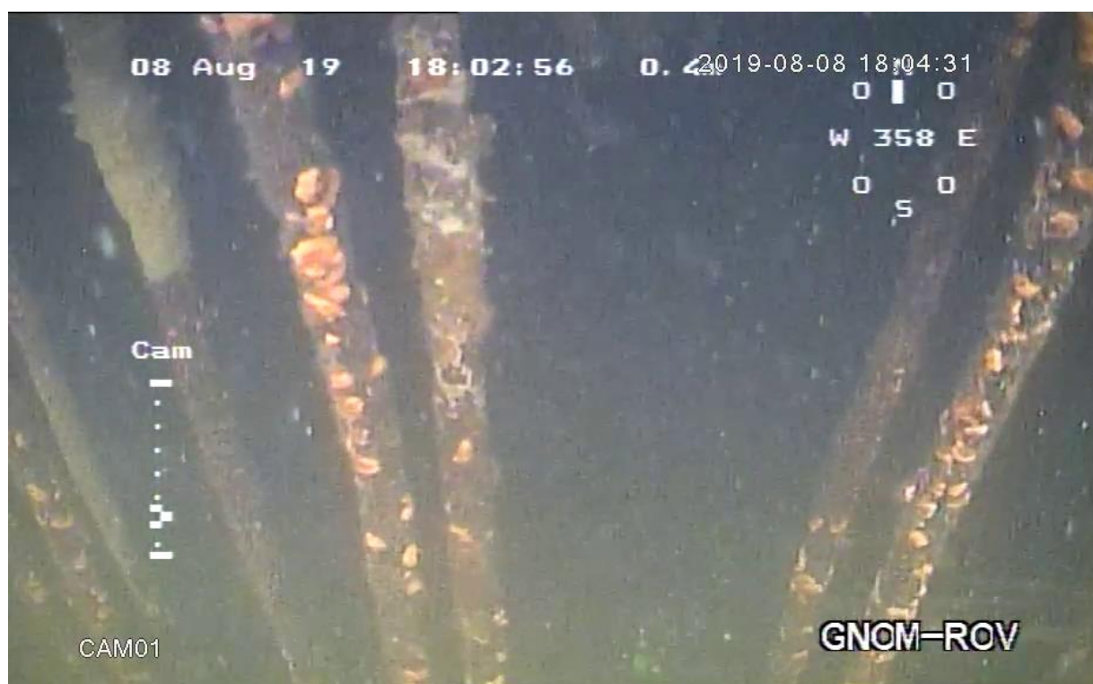
Полное разрушение железобетонных свай
