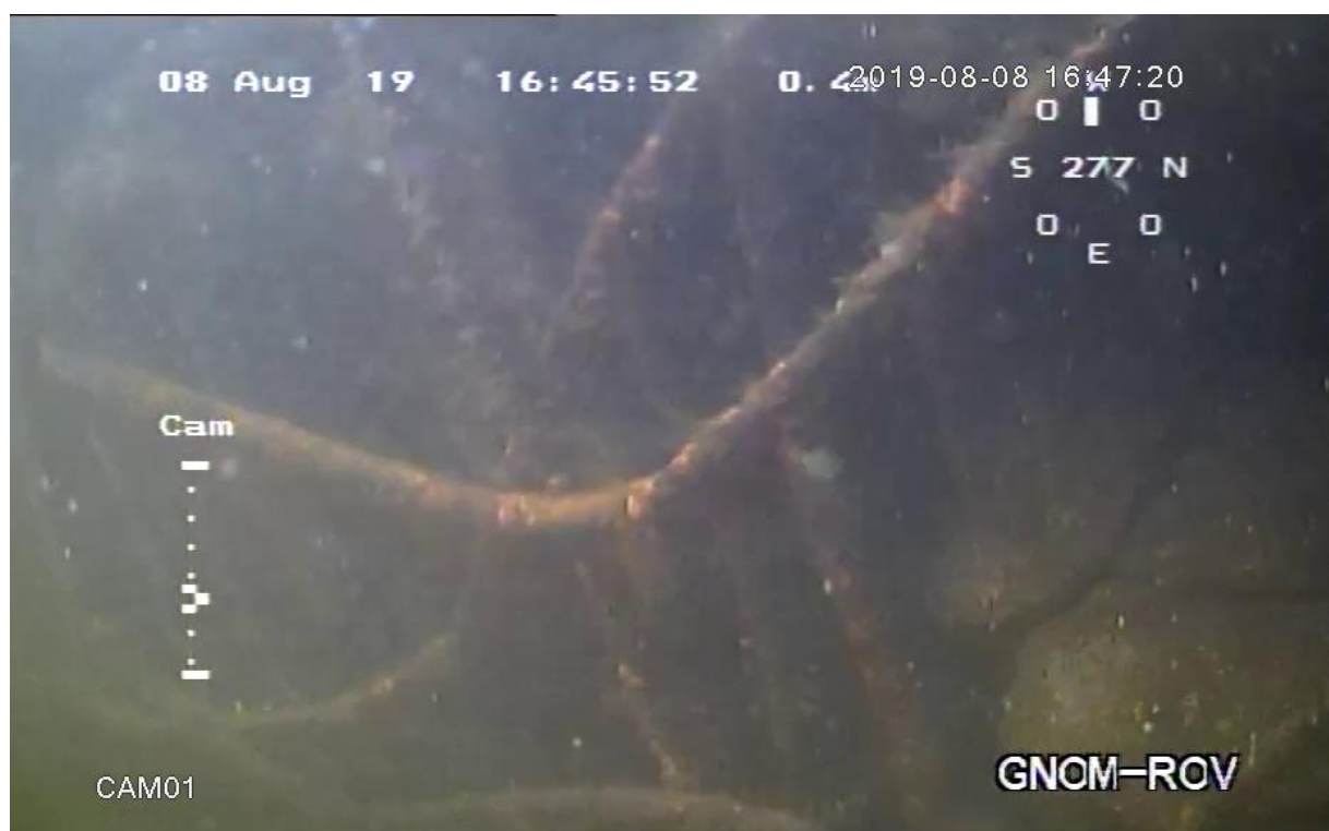
Полное разрушение железобетонных свай
