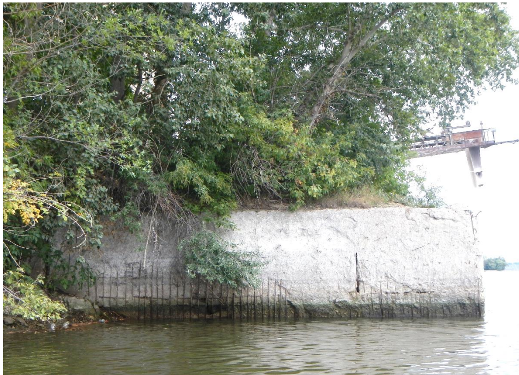
Разрушение защитного слоя бетона, оголение и коррозия арматуры левого открьлка
