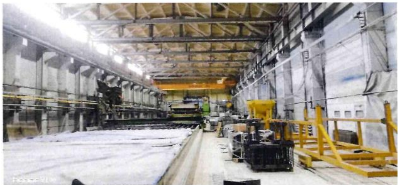
Рис. Г.5. Общий вид производственных помещений
