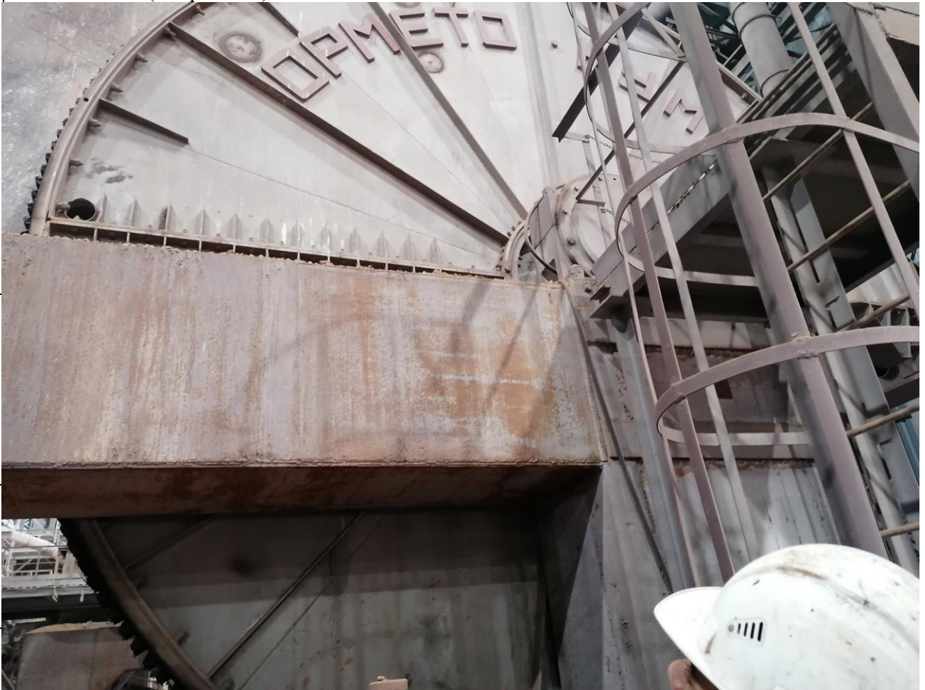
Рис. 5.1. Обрамление колонн и приварка балки.
