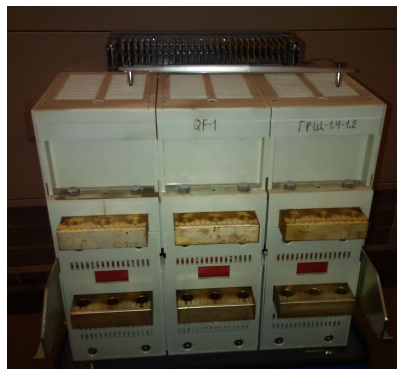
Вводные и секционные выключатели на выкатной тележке
