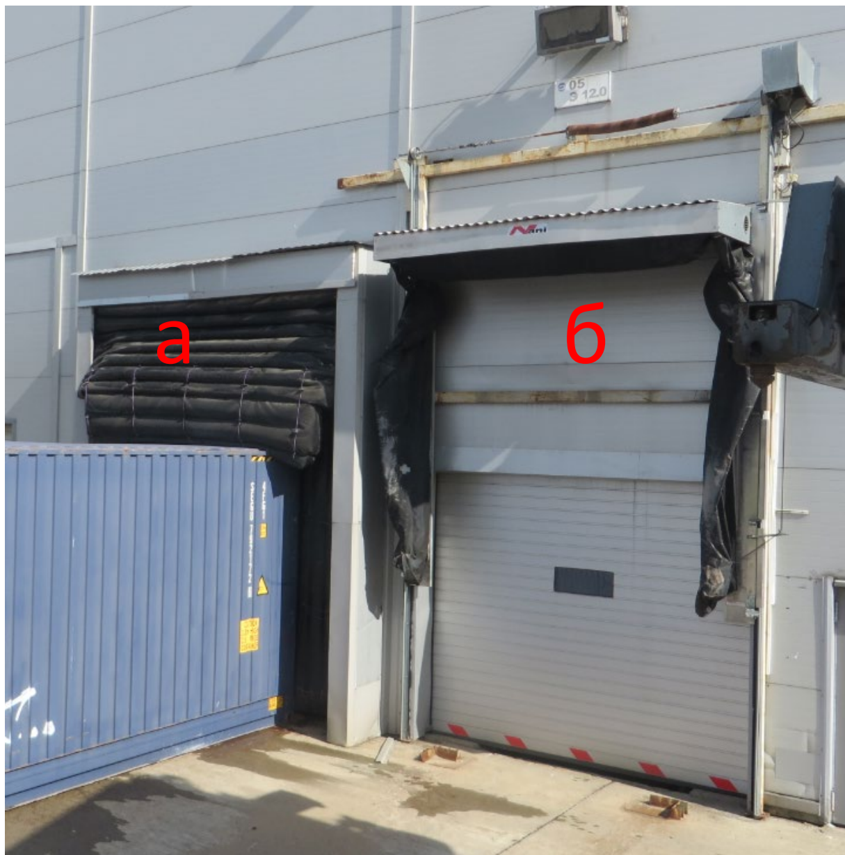
Рисунок 1. Герметизаторы со стационарным (а) и опускаемым (б) проемом.
