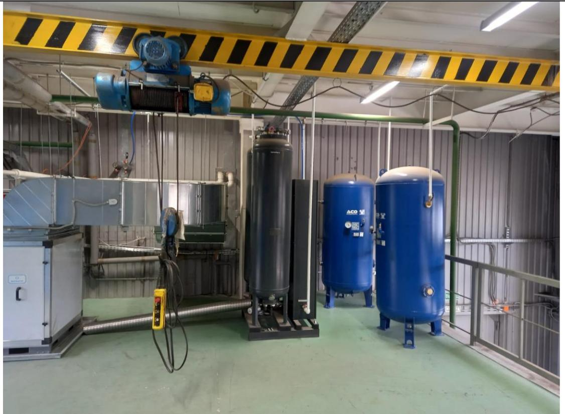
*Помещение «Вентиляционная – азотная - компрессорная» на 1,5-ом (антресольном) этаже в осях 6''-7''/А\*-В\* - Предназначено для размещения оборудования приточной вентиляции П1 (общеобменная вентиляция цехов 1 и 2), так же в данном помещении размещена установка - «Генератор Азота» со вспомогательным оборудованием и воздушный компрессор с отдельно стоящим осушителем.*
